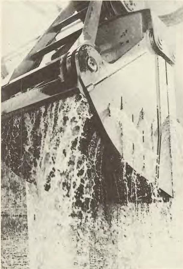
Der Greifbagger holt an die sieben Kubikmeter Schotter aus der Tiefe.
